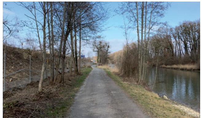
Rheineck: Chaussierter Weg zwischen Autobahn und Altem Rhein (Foto: asa AG)
